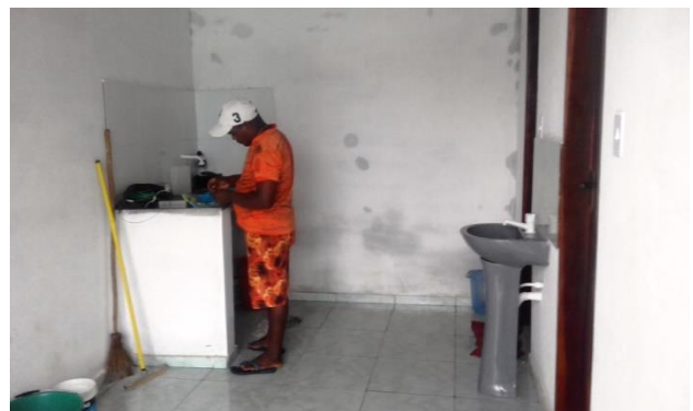
Die Installation der Waschküche.
