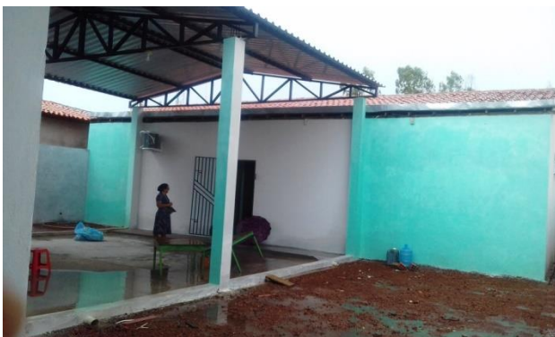
Das Dach hält schon dem Regen stand.
